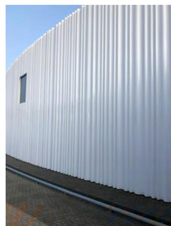
Aus doppelt geschichtetem Acrylglas hergestellt, besteht die Fassade aus sechs verschiedenen "Wellen" zusammengesetzter Muster, die eine sich nicht wiederholende, scheinbar willkürliche Oberfläche abbilden – fast wie ein frei hängender Vorhang, der der Konstruktion eine Leichtigkeit verleiht, die die eigentliche Größe des Gebäudes verschleiern und schließlich reduzieren soll.
